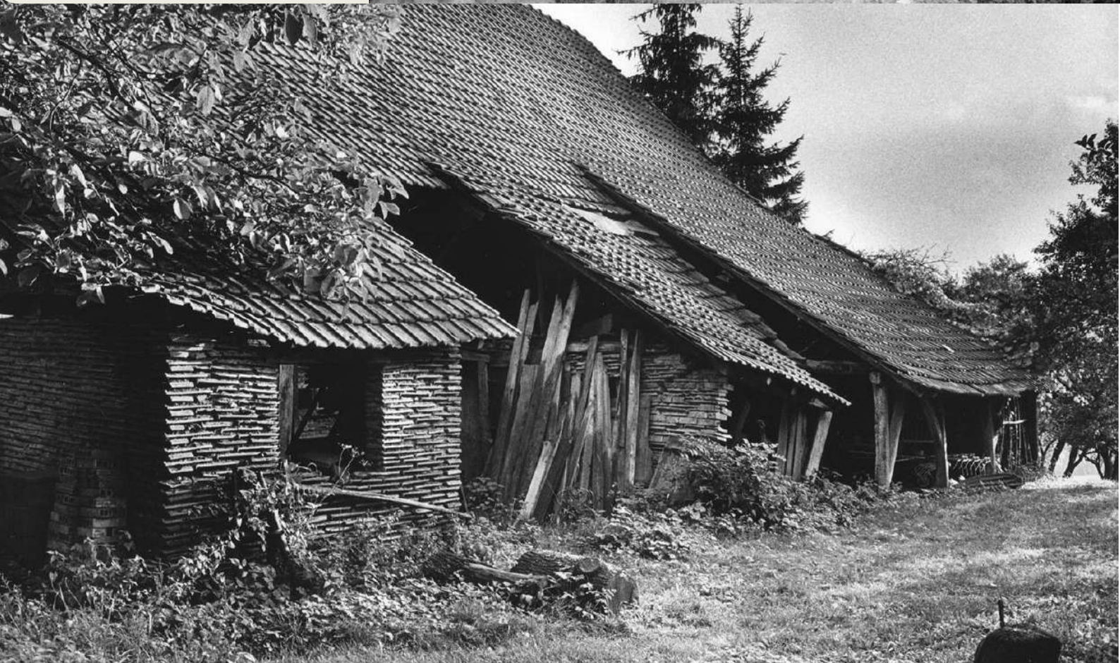
▼ La maison du même Heckly Alfred vue de l'arrière. On remarque la construction des murs en tuiles de récupération. La maison a été détruite au début des années 2000.
